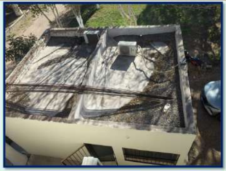
IMPERMEABILIZACIÓN DE 1 352.67 M 2 EN 3 EDIFICIOS CON CARTON ARENADO Y 2 CON ELASTOMERICO DANDO UN TOTAL DE
