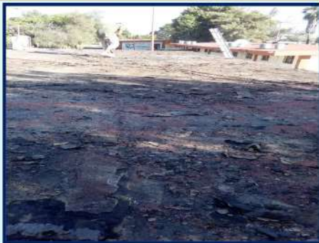
IMPERMEABILIZACIÓN DE 215.46 M 2 DE 1 EDIFICIO CON CARTÓN ARENADO
