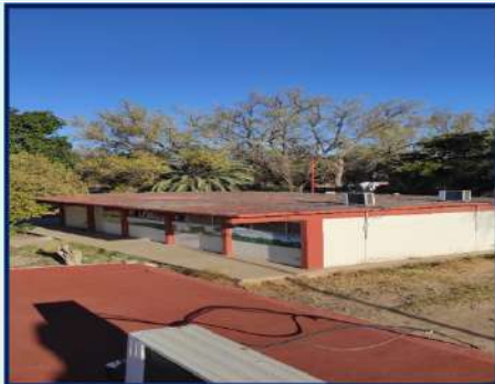
IMPERMEABILIZACIÓN DE 215.46 M 2 DE 1 EDIFICIO CON CARTÓN ARENADO
