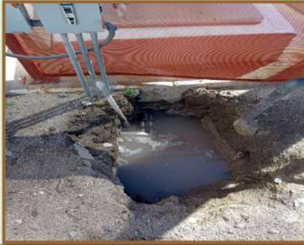
TRABAJOS DE MANTENIMIENTO A RED HIDRÁULICA DAÑADA EN ÁREA DE CISTERNA
