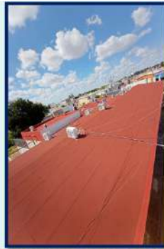
IMPERMEABILIZACIÓN DE 686.9 M 2 DE 4 EDIFICIOS CON CARTÓN ARENADO
