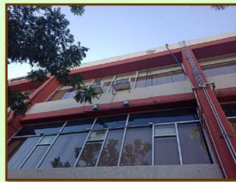
ENJARRE EN MURO DEL EDIFICIO B, IMPERMEABILIZACIÓN DE UNA SECCIÓN, COLOCACIÓN DE SOPORTE DE MINI SPLIT
