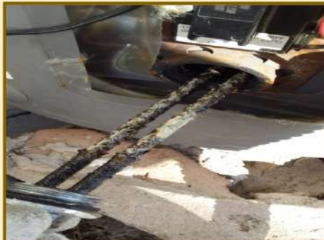
TRABAJOS DE SUSTITUCIÓN DE RESISTENCIAS Y ADECUACIONES EN RED HIDRÁULICA EN BOILERS POR PROBLEMAS EN ENFRIAMIENTO.
