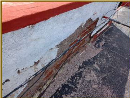
TRABAJOS DE IMPERMEABILIZACIÓN Y ENJARRE EN MUROS DE PRETEL PARA SOLUCIONAR LAS FILTRACIONES
