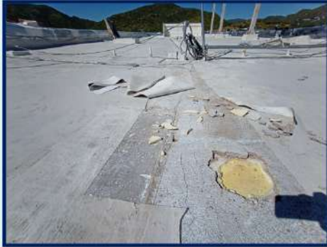
IMPERMEABILIZACIÓN DE 724.76 M 2 EN 1 EDIFICIO Y 7 ÁREAS ESPECIFICAS CON ELASTOMÉTICO
