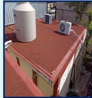
IMPERMEABILIZACIÓN DE 686.9 M 2 DE 4 EDIFICIOS CON CARTÓN ARENADO
