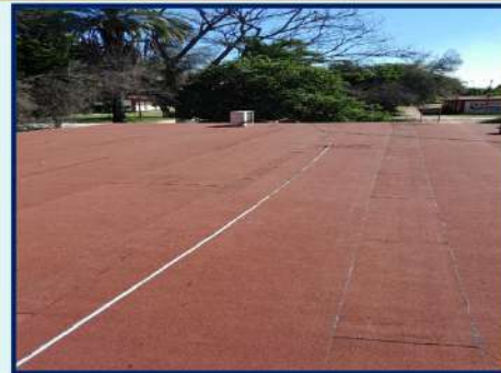
IMPERMEABILIZACIÓN DE 215.46 M 2 DE 1 EDIFICIO CON CARTÓN ARENADO
