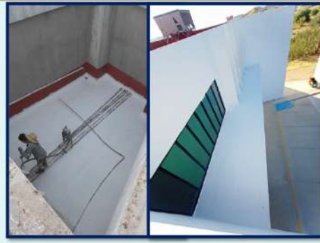
IMPERMEABILIZACIÓN DE 724.76 M 2 EN 1 EDIFICIO Y 7 ÁREAS ESPECIFICAS CON ELASTOMÉTICO
