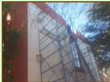
ENJARRE EN MURO DEL EDIFICIO B, IMPERMEABILIZACIÓN DE UNA SECCIÓN, COLOCACIÓN DE SOPORTE DE MINI SPLIT
