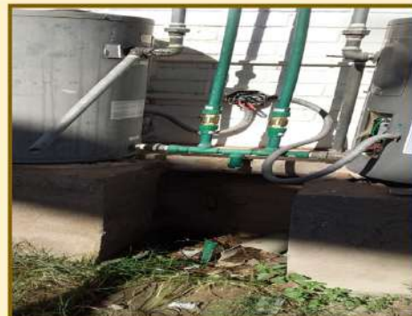
TRABAJOS DE SUSTITUCIÓN DE RESISTENCIAS Y ADECUACIONES EN RED HIDRÁULICA EN BOILERS POR PROBLEMAS EN ENFRIAMIENTO.
