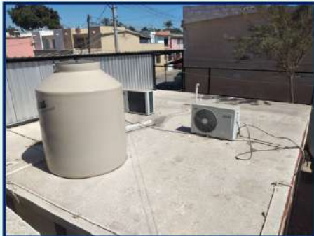
IMPERMEABILIZACIÓN DE 686.9 M 2 DE 4 EDIFICIOS CON CARTÓN ARENADO
