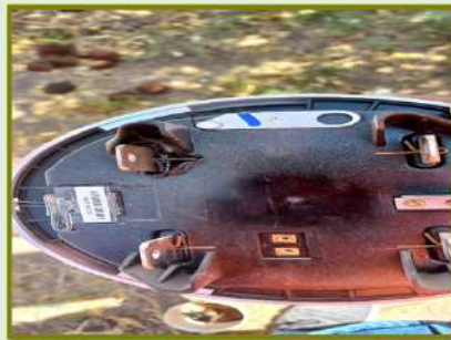
REPARACIÓN ELÉCTRICA DEL CORTO OCURRIDO EN LA MUFA, SUSTITUCIÓN DE LA BASE DE MEDICIÓN Y RECABLEO DE TRAMO
