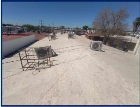
IMPERMEABILIZACIÓN DE 686.9 M 2 DE 4 EDIFICIOS CON CARTÓN ARENADO
