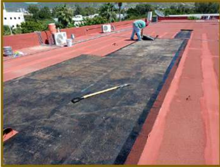
TRABAJOS DE IMPERMEABILIZACIÓN Y ENJARRE EN MUROS DE PRETEL PARA SOLUCIONAR LAS FILTRACIONES
