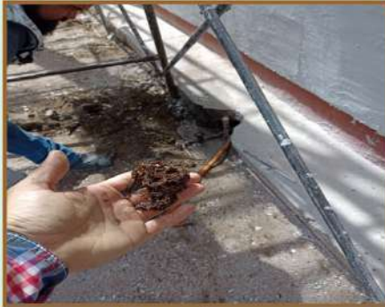
REHABILITACIÓN DE TUBERÍAS TAPONADAS CON RAÍCES Y SUSTITUCIÓN DE UN ÁREA DE PISO DAÑADA EN UN AULA.
