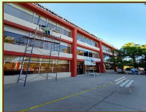
ENJARRE EN MURO DEL EDIFICIO B, IMPERMEABILIZACIÓN DE UNA SECCIÓN, COLOCACIÓN DE SOPORTE DE MINI SPLIT
