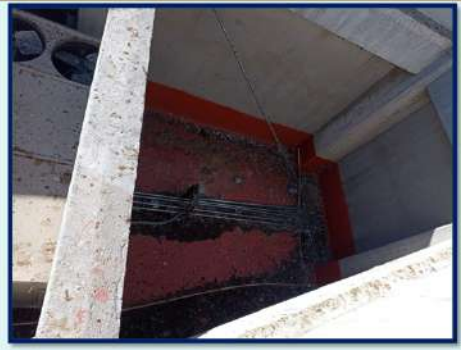
IMPERMEABILIZACIÓN DE 724.76 M 2 EN 1 EDIFICIO Y 7 ÁREAS ESPECIFICAS CON ELASTOMÉTICO
