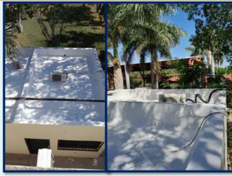
IMPERMEABILIZACIÓN DE 1 352.67 M 2 EN 3 EDIFICIOS CON CARTON ARENADO Y 2 CON ELASTOMERICO DANDO UN TOTAL DE
