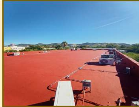
TRABAJOS DE IMPERMEABILIZACIÓN Y ENJARRE EN MUROS DE PRETEL PARA SOLUCIONAR LAS FILTRACIONES
